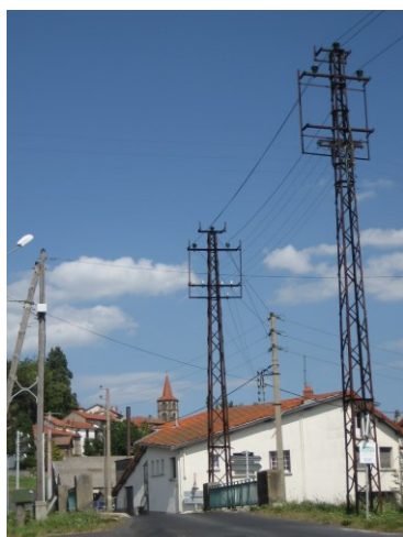
rue des Potelleries avant
